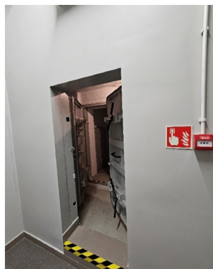
⑤ Budowla ochronna z zainstalowanym system sygnalizacji pożarowej (SSP)
