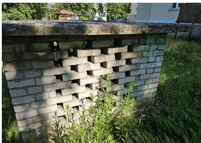
11 Wyjścia ewakuacyjne (kominki ewakuacyjne) budowli ochronnej, które jednocześnie pełnią funkcję nawiewu świeżego powietrza do wnętrza obiektu
