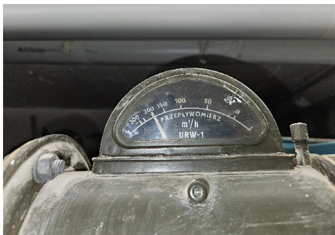
10 Faktyczne wskazania przepływowomierza z podjętych prób uruchomienia urządzeń filtrowentylacyjnych zamontowanych w budowlach ochronnych fot. archiwum prywatne autora
