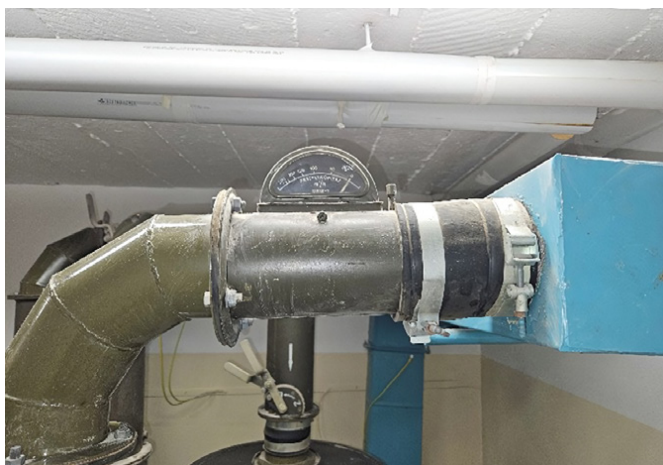
10 Faktyczne wskazania przepływowomierza z podjętych prób uruchomienia urządzeń filtrowentylacyjnych zamontowanych w budowlach ochronnych fot. archiwum prywatne autora
