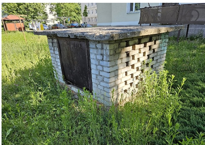
11 Wyjścia ewakuacyjne (kominki ewakuacyjne) budowli ochronnej, które jednocześnie pełnią funkcję nawiewu świeżego powietrza do wnętrza obiektu
