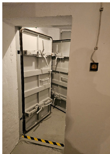
② Przedsiónek z drzwiami OH ze stali o grubości co najmniej 6 mm, odległość między drzwiami nie mniejsza niż 1 m na drodze promieniowania
