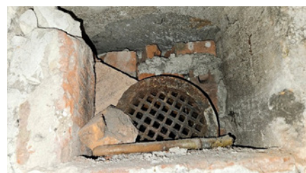
12 Uszkodzona wywiewna kłapa schronowa oraz przetykany dołot powietrza do budowli ochronnej
