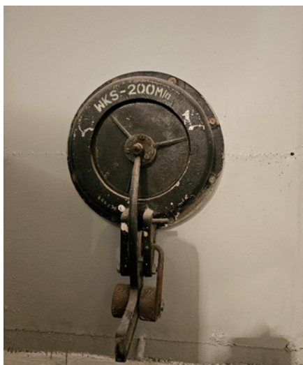
11 Zabezpieczenie otworu wylotu powietrza do budowli ochronnej za pomocą wywiewnej kłapy schronowej WKS-200M i WKS 150M
