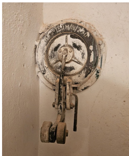
11 Zabezpieczenie otworu wylotu powietrza do budowli ochronnej za pomocą wywiewnej kłapy schronowej WKS-200M i WKS 150M
