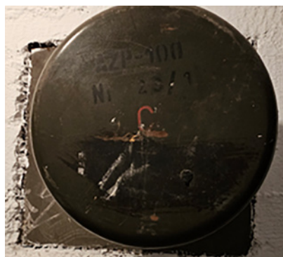
8 Zabezpieczenie otworu dolotu powietrza do komory rozprężnej za pomocą automatycznego zaworu przeciwybuchowego (AZP-100) lub filtra mineralnego
