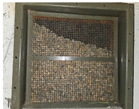
8 Zabezpieczenie otworu dolotu powietrza do komory rozprężnej za pomocą automatycznego zaworu przeciwybuchowego (AZP-100) lub filtra mineralnego
