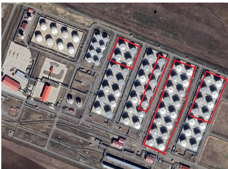
Baza paliw w Proletarsku z zaznaczonymi zbiornikami, które uległy zniszczeniu
