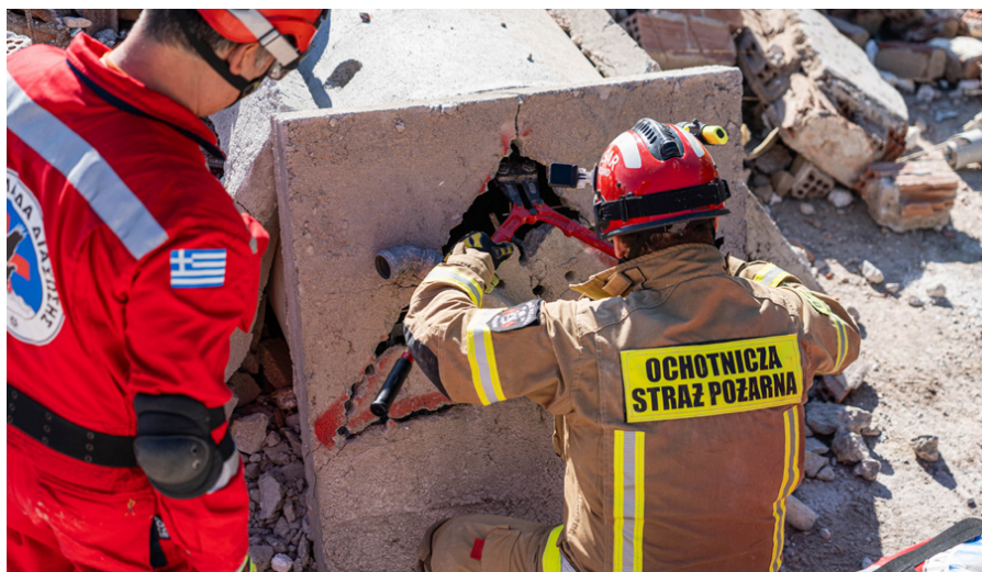
Usuwanie przeszkody za pomocą narzędzi ratowniczych
