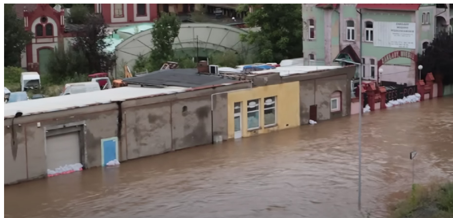
Przykład, że można się ratować. Kłodzko, zakłady mięsne: zabezpieczenie terenu zakładu z wykorzystaniem murów budynków, bram i worków z piaskiem przed wodą ekstremalnej fali wezbraniowej z zerwanej tamy
