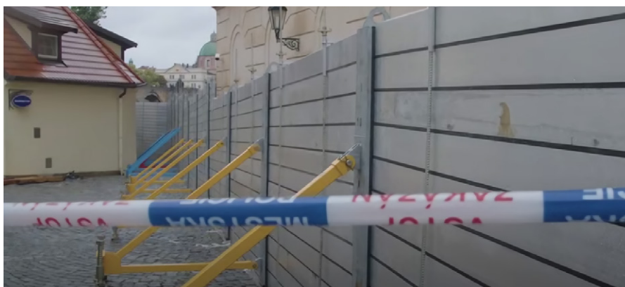
A w Pradze w obronie przed Wełtawą ustawiony został przenośny system zapór prefabrykowanych
