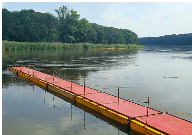
➔ Sprawiona zapora pomostowa (sztywna) fot. arch. KP PSP w Nowej Soli
