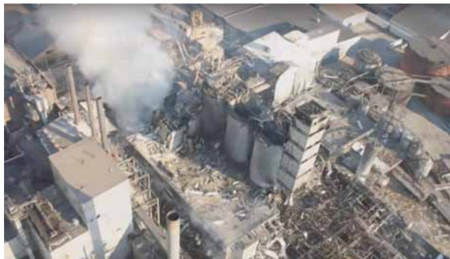
⬆ Dym nad zniszczoną fabryką fot. kadr z „Inferno: Dust Explosion at Imperial Sugar” / USCSB / YouTube
