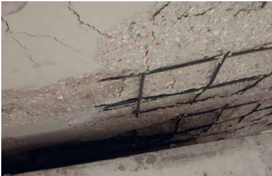
Ryzyko zniszczenia konstrukcji na skutek eksplozyjnego odpryskiwania betonu fot. Wojciech Szymkuć
