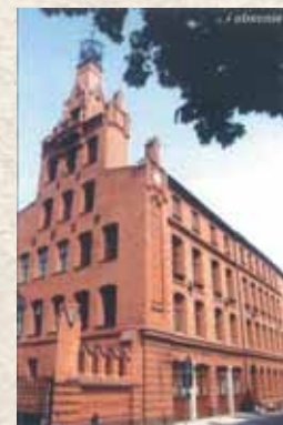
Stan budynku w 2003 r. fot. PP 6/2003, s. 30
