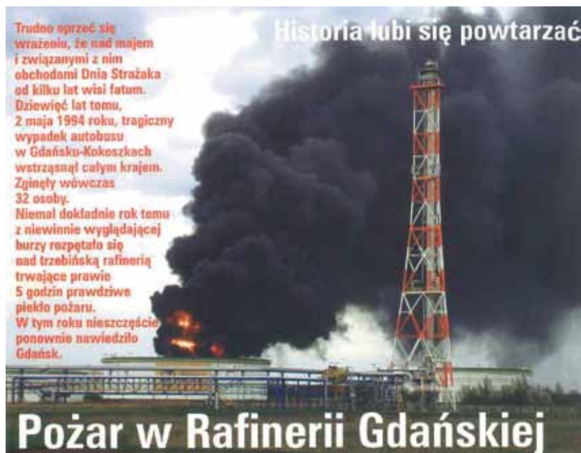
Tragiczny pożar w Rafinerii Gdańskiej fot. PP 6/2003, s. 10
