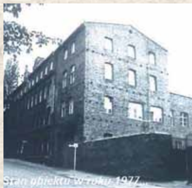
Budynek zabytkowej strażnicy w 1977 r. fot. PP 6/2003, s. 30
