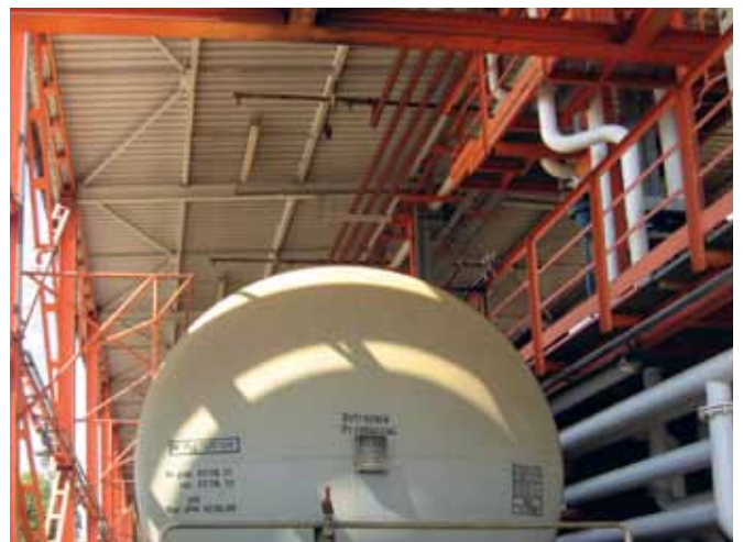
Stale urządzenia gaśnicze zabezpieczające front załadunku cystern kolejowych
