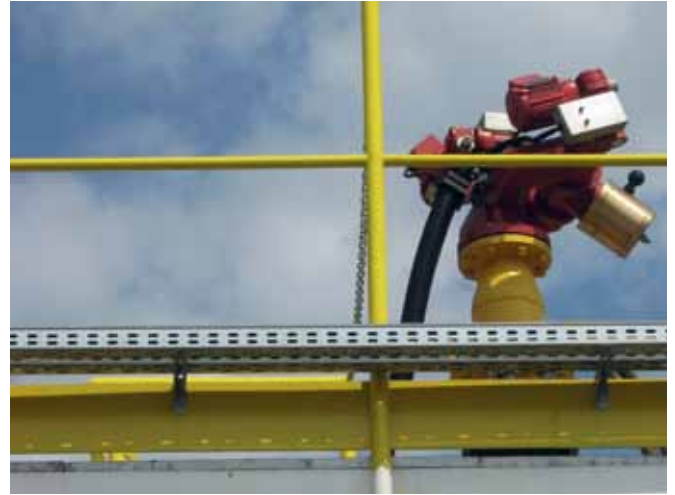
Działko pianowe sterowane elektrycznie zamontowane na podeście
