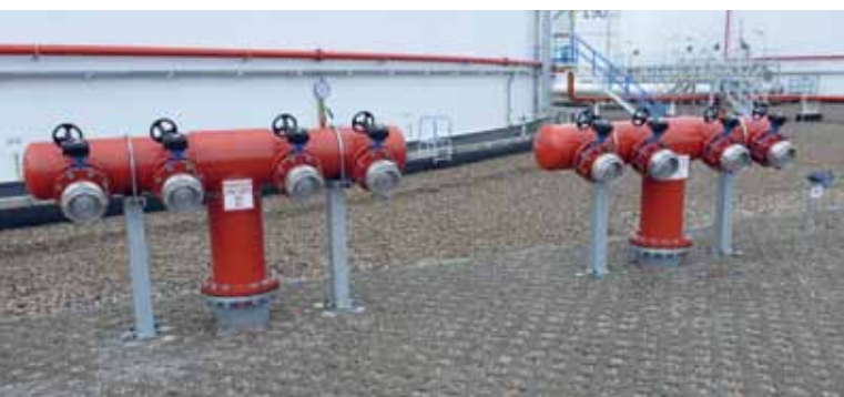
4 Wysokowydajne punkty poboru wody
