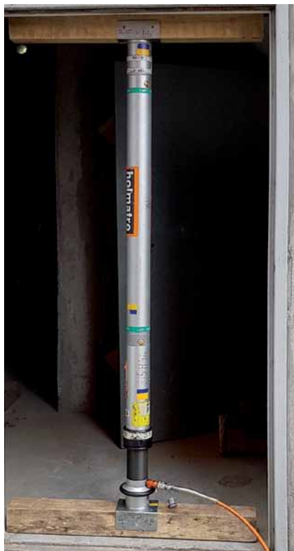
Fot. 1. Stabilizacja podporą typu T. Podciąg i podwalina z drewnianych kantówek, słup z ratowniczego systemu stabilizacji
