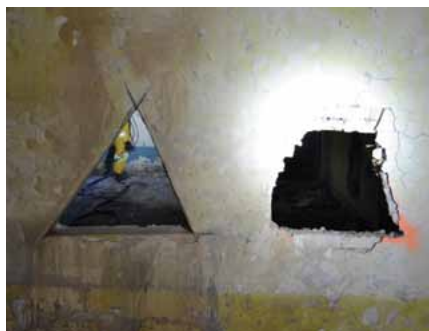
Fot. 4. Przykłady przebić. Po lewej: przebicie poziome, nieudarowe, czyste. Po prawej: przebicie poziome, udarowe, brudne
