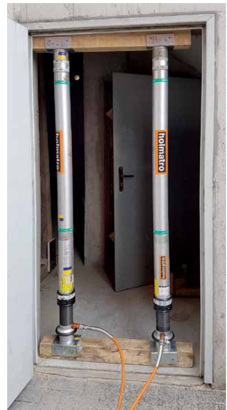
Fot. 2. Stabilizacja otworu drzwiowego. Podciąg i podwalina z drewnianych kantówek, słupy z ratowniczego systemu stabilizacji
