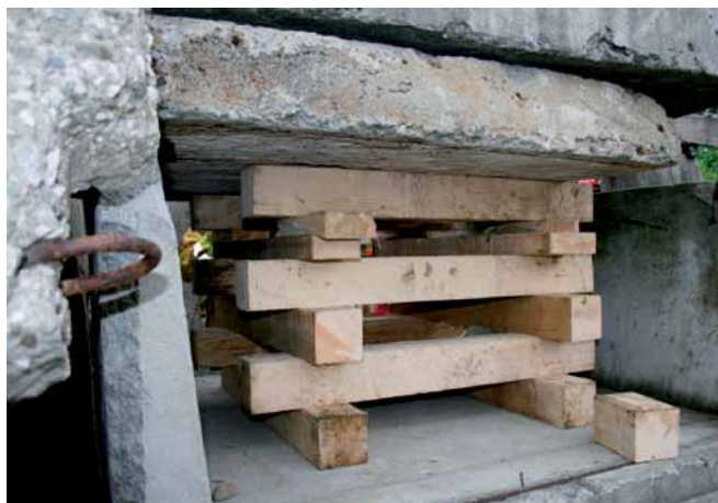
Fot. 3. Stabilizacja otworu drzwiowego podporą bezgwoździową układaną w stos 2x2
