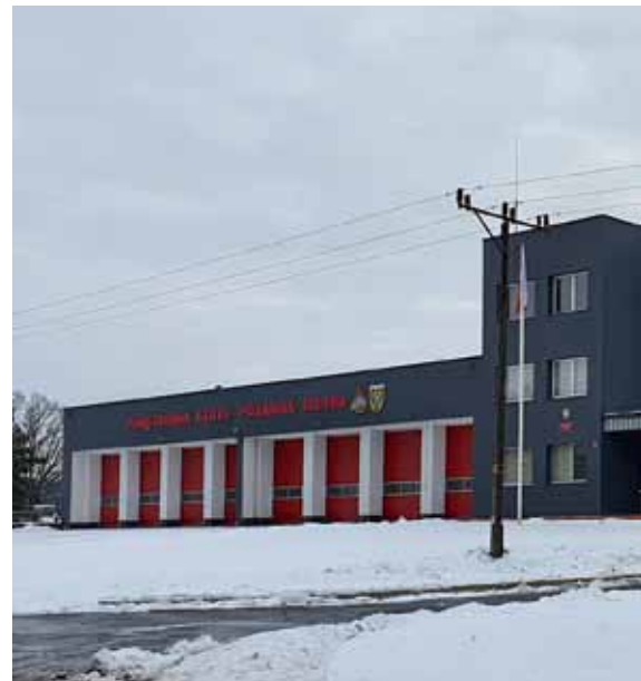
📍 Instalacja fotowoltaiczna na budynku Komendy Powiatowej PSP w Sieradzu
