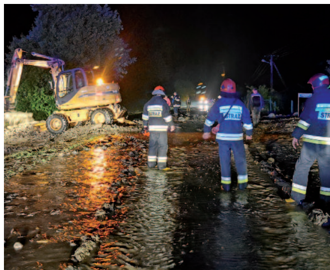
Udrażnianie drogi w miejscowości Piątkowa w powiecie przemyskim po przejściu fali powodziowej. Na zdjęciu strażacy z JRG Przemysł i ochotnik z OSP Tarnawka
