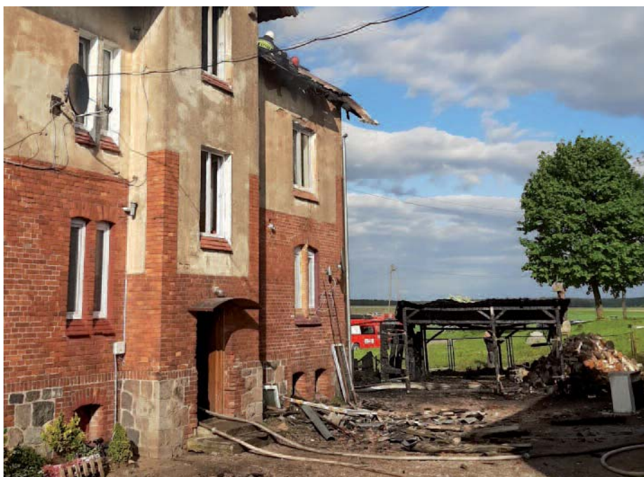
Budynek dotknięty pożarem oraz spalone garaże
