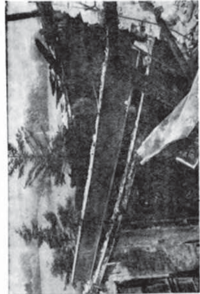
Fragment wzmocnionej konstrukcji nośnych stropu strychu po poparzeniu
