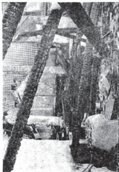
Wypalona część strychu nad korytarzem i dwiema salami chorych
