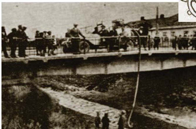
Fotografia prasowa z 1932 r. przedstawiająca próbę ssania z głębokości 7,5 m. Motopompa znajduje się na dachu samochodu
