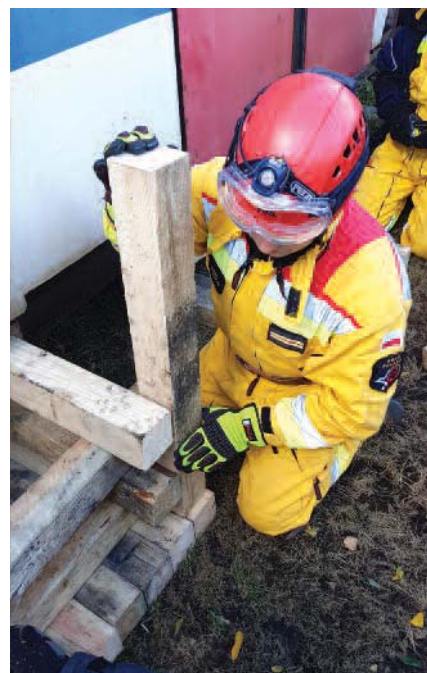
3. Praktyczny sposób na utrzymanie osiowości stosu i odległości poza węzłami. Tu widoczna pierwsza warstwa ułożona w postaci pełnej podstawy
