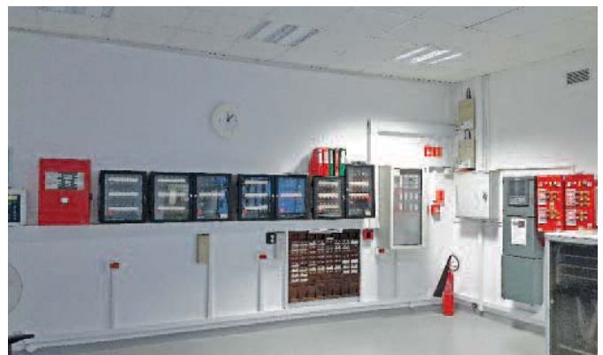
Centrale systemów sygnalizacji pożaru (SSP) w Centrum Monitoringu BN
