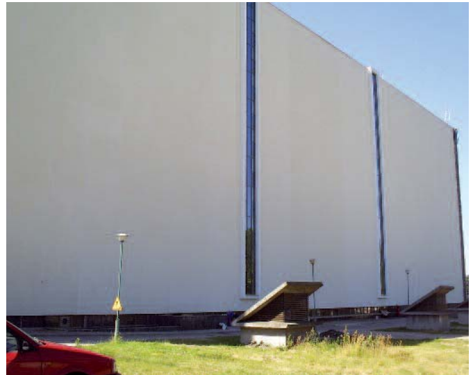
Elewacja północna budynku magazynowego po modernizacji (wymiana ściany szklanej na pełną)
