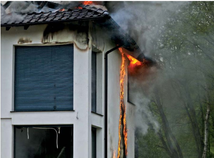
2. Pożar dachu w nowym domu jednorodzinym
