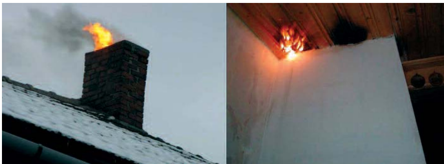
Fot. 2. Pożar sadzy w kominie – przenoszenie się ognia na konstrukcję budynku
