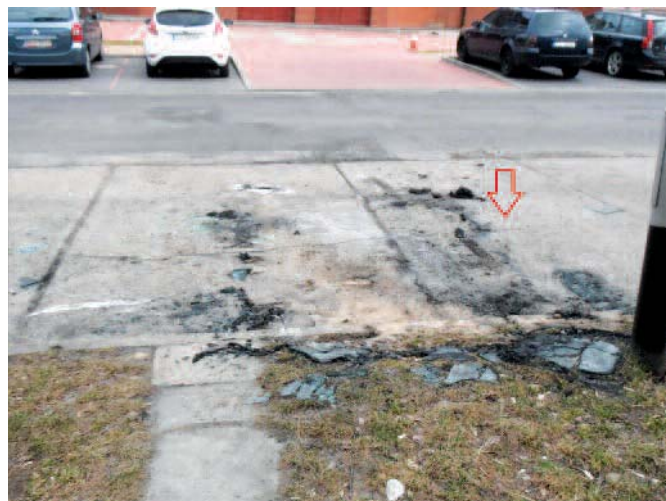
fot. 3. Miejsca lokalizacji szkła okiennego na podłożu
