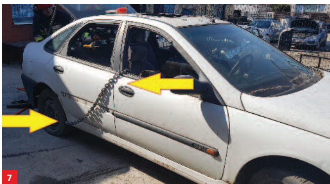
Zgniot dwustronny auta o różnej sile za pomocą rozpieracza ramieniowego i łańcuchów
