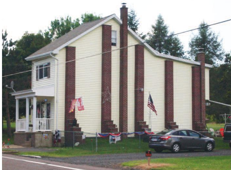
Fragment dawnego szeregowca. Po relokacji wyburzono domy przesiedlonych mieszkańców. Lokatorzy tego postanowili pozostać w mieście. Widoczne wzmocnienia ścian w miejscu, gdzie kiedyś znajdował się drugi budynek
