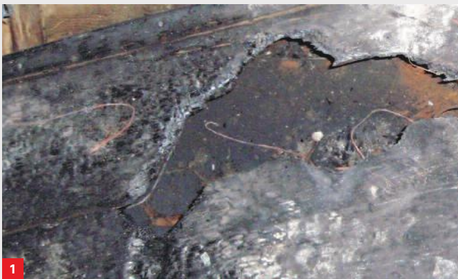
1 Wypalenia na podłodze o kształtach odpowiadających kształtowi rozlanej cieczy palnej
