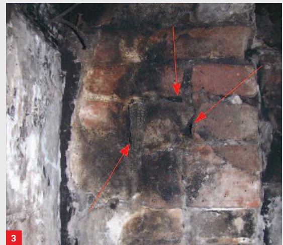
3 Śladami mogącymi wskazywać na powstanie pożaru od przewodu kominowego mogą być np. rysy i pęknięcia w przewodzie kominowym z widocznymi osmaleniami w tych szczelinach
