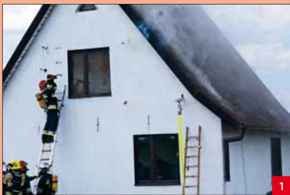
fot. 1. Moment przewiercenia ściany w celu podania mgły wodnej. Po prawej widoczna lanca innego typu (polskiej produkcji, opisana w PP 7/2016), zabezpieczająca puste przestrzenie dachowe podczas ćwiczenia.
