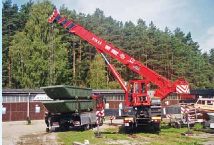
Wodowanie na jeziorze elementów stanowiska
