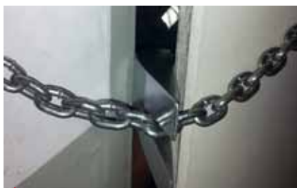
Technika wyrwania łańcucha. Należy złapać łańcuch w widły, zaprzeć się hooliganem o ramę i naciskając narzędzie w kierunku ściany, wyrwać z niej mocowanie łańcucha
