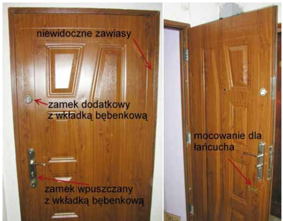
Rozpoznanie drzwi przed wyważeniem: drzwi nowe, drewniane, otwierane na zewnątrz, widoczne dwa zamki – wpuszczany i dodatkowy, oba z wkładką bębennową, zawiasy niedostępne. Ocena możliwości pracy: brak podejścia dla wyważarki, brak dostępu do zawiasów dla piły, możliwe wyważenie hooliganem i młotem oraz wybite wkładki i użycie własnej. Drzwi – jak się okazało – były otwarte...
