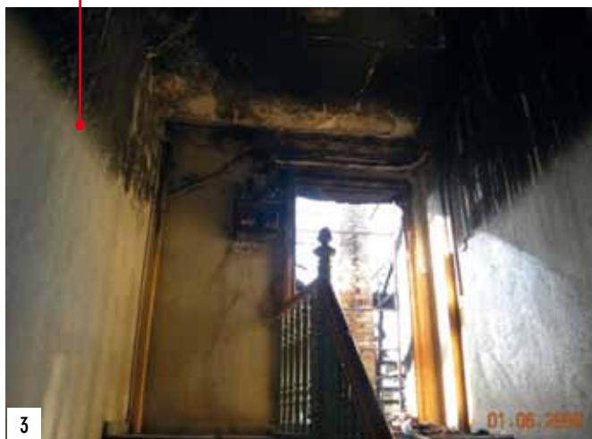
Dolna granica śladu sadzy na powierzchni ściany klatki schodowej przy wejściu na poddasze
