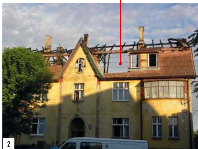
Brak elementów konstrukcyjnych dachu w dolnej części poddasza
