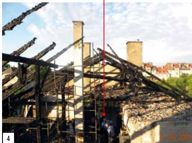
Wejście na poddasze z klatki schodowej
