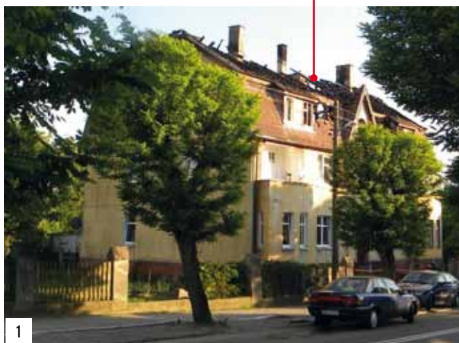
Spalone elementy konstrukcji dachu w górnej części poddasza
