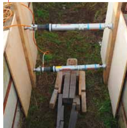
Zamontowanie pierwszej pary paneli
