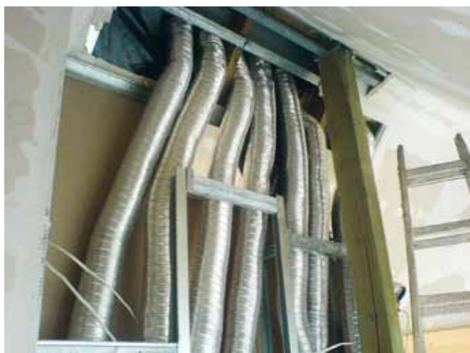
u góry: „Przewody wentylacyjne” wyprowadzone na strychu
