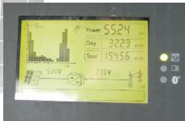
Płyta czołowa inwertera z widocznymi wartościami napięć po stronie DC 534V i AC 233V
