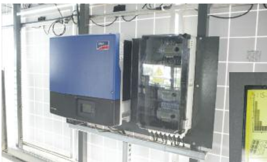
Inwerter (po lewej) i szafka z zabezpieczeniami po stronie DC (po prawej). Z tyłu panele ustawione w pionie oraz widoczne wtyczki i przewody je łączące
