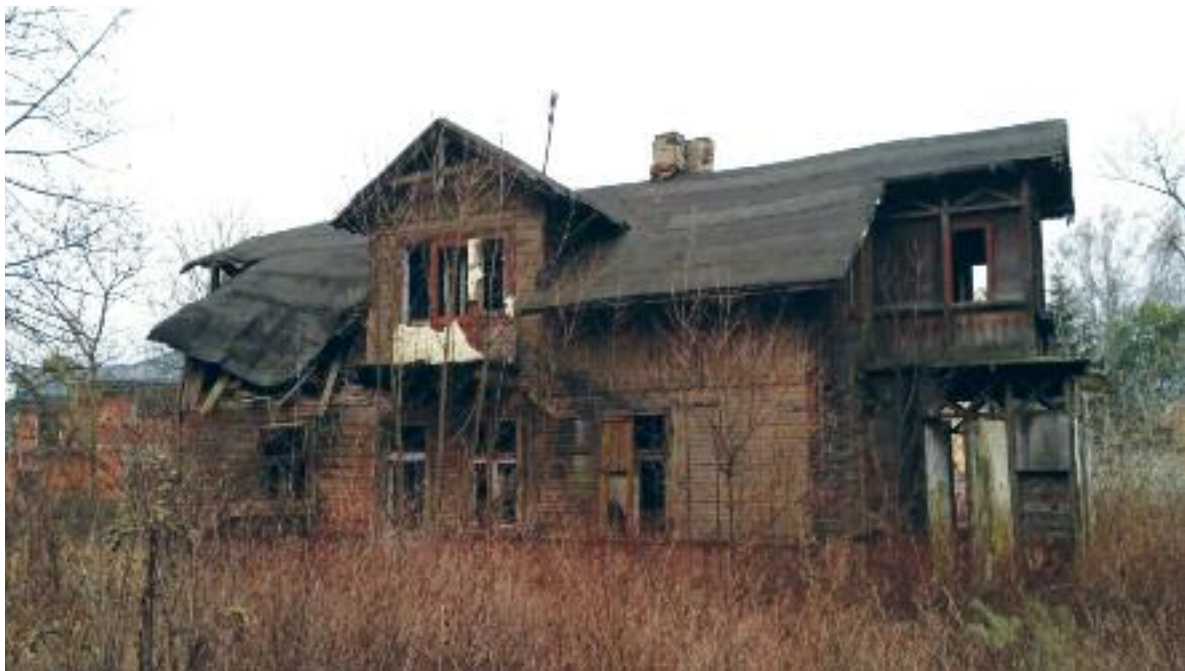
Opuszczony dom mieszkalny w woj. mazowieckim. Palny materiał budowlany sprzyja gwałtownemu rozwojowi pożaru, a naruszona już konstrukcja – zawaleniu budynku, fot. Marek Wyrozębki
