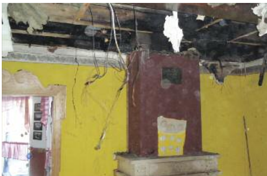
Miejsce ogniska pożaru zlokalizowane nad czopuchem, fot. Tomasz Sawicki (3)
