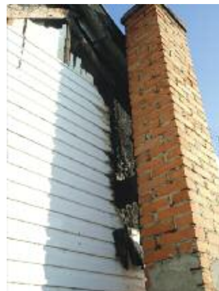
Nieprawidłowe wyprowadzenie dymu z komory spalania. Podłączenie wykonano przez ścianę palną
