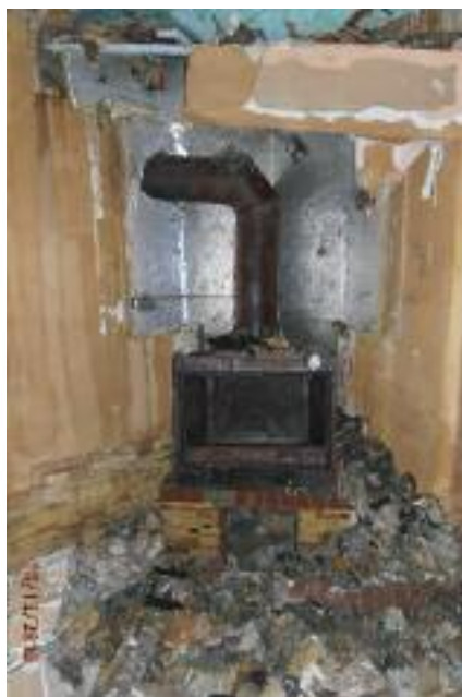
Kominek z paleniskiem zamkniętym po pożarze
