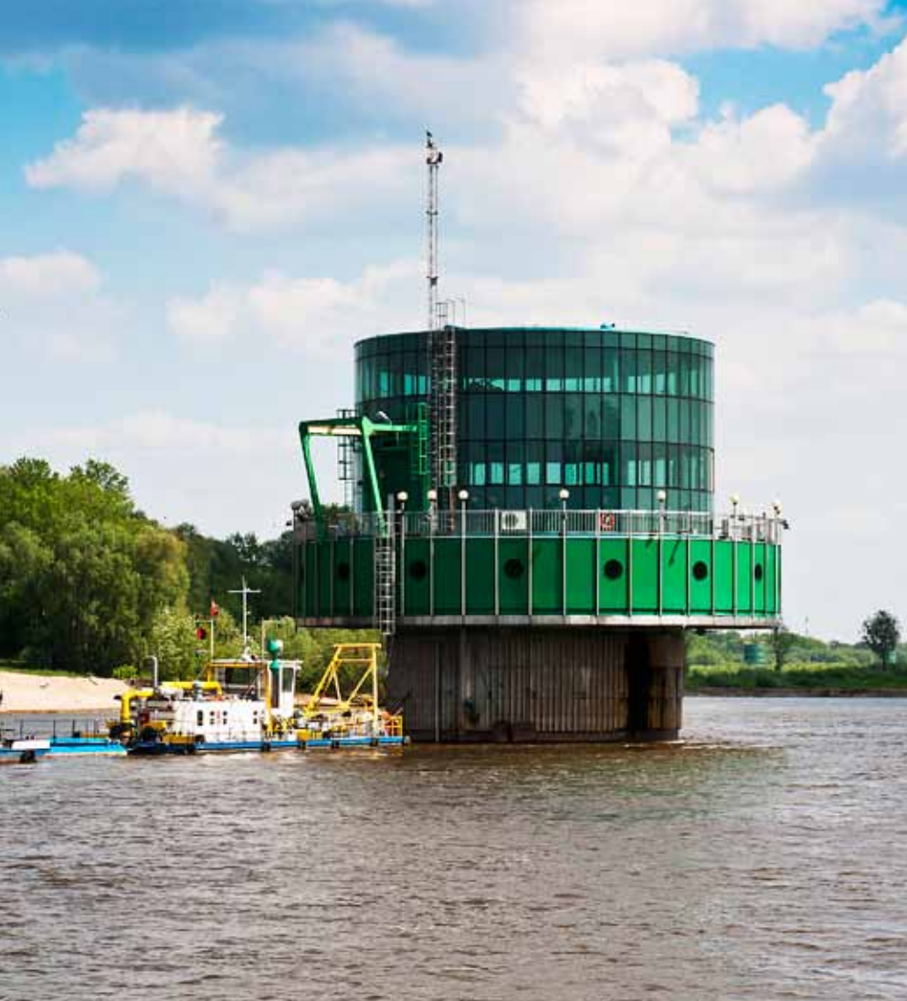
„Gruba Kaśka” – stacja pomp Wodociągów Warszawskich czerpie wodę spod dna Wisły
