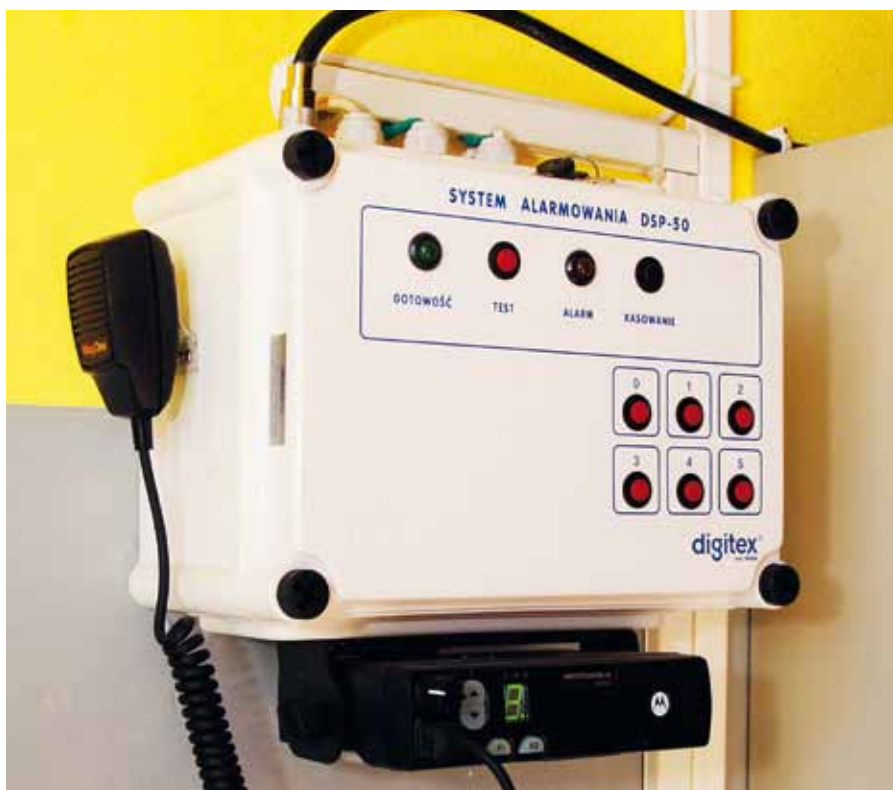
Centrałka systemu alarmowania DSP-50
