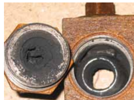
↑ Zwężenie średnicy wewnętrznej zaworu i przewodu zbiorczego wiązki butli acetylenowych na skutek osadzania się sadzy
