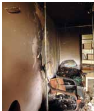
Miejsce pożaru w mieszkaniu doszczelnionym po wykonaniu pierwszego testu
