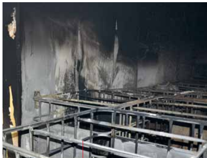
Brama oddzielenia przeciwpożarowego między strefami III i II zablokowana pojemnikami DPPL
