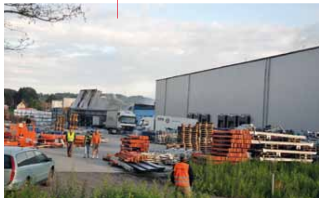
Magazyn wysokiego składowania – strefa pożarowa VIII. Budynek w kolorze niebieskim to biura logistyki, stanowiące strefę pożarową VII
