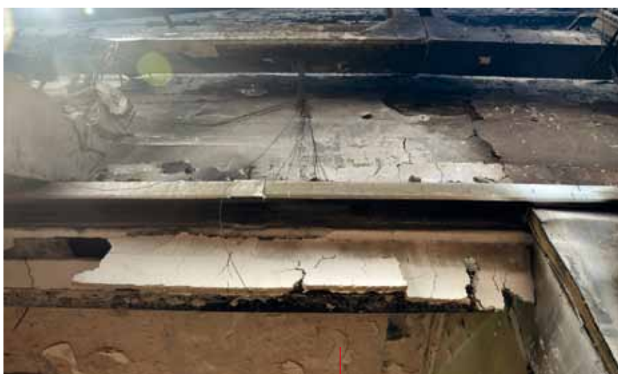
Brama znajdująca się między magazynem produktów gotowych a strefą produkcji mokrej – część magazynu produkcyjnego
