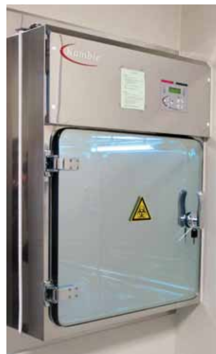
↑ Śluza podawcza, przez którą przekazywane są substancje i odpady z laboratorium kierowane do sterylizacji
