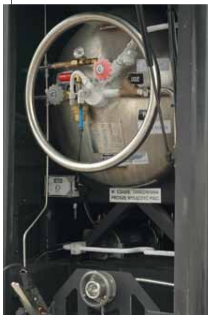
Rys. 7. Widok przygotowanej do tankowania instalacji paliwowej
