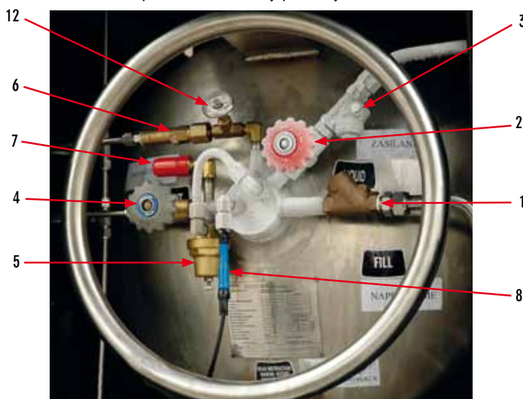
Rys. 2. Rozmieszczenie zaworów na głowicy zbiornika LNG
