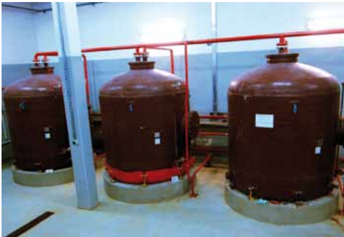
Stanowisko rozdzielcze strefowe urządzeń gaśniczych pianowych ←
