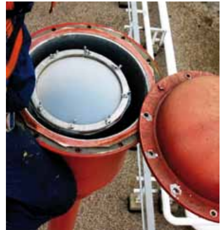
Garnek pianowy z zamkiem szklanym, zabezpieczającym przed dostaniem się oparów do instalacji →
