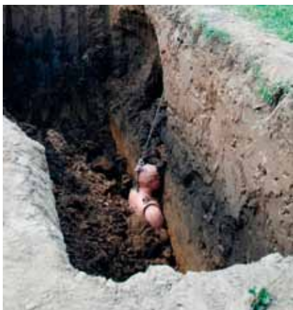
Podjęście do wykopu
