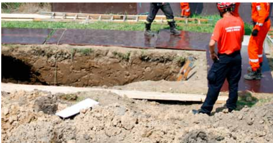
Umocnienie brzegów wykopu
