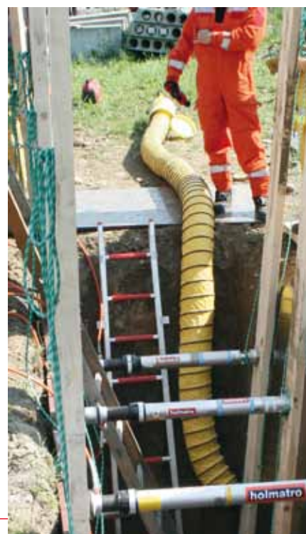
Prowadzenie wentylacji mechanicznej wykopu
